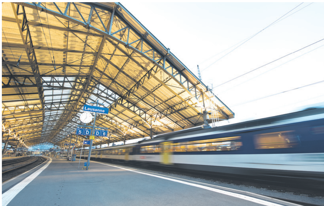
La grande halle vue de l'ouest.
